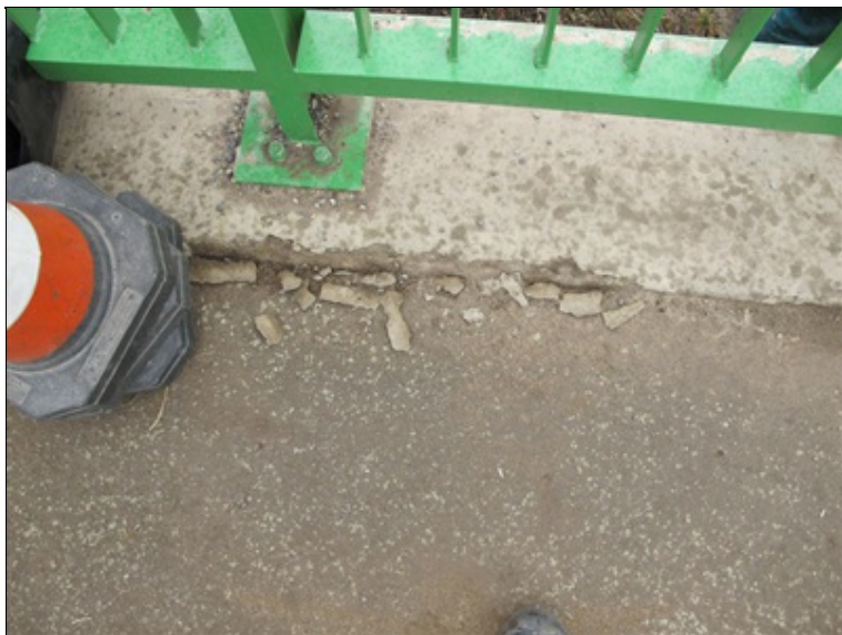
Převýšená vozovka a rozpad říms.
