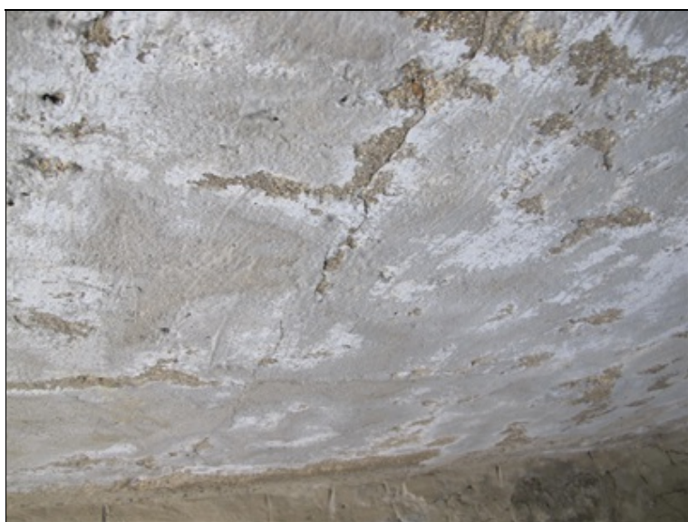
Podhled NK - podélné trhliny.
