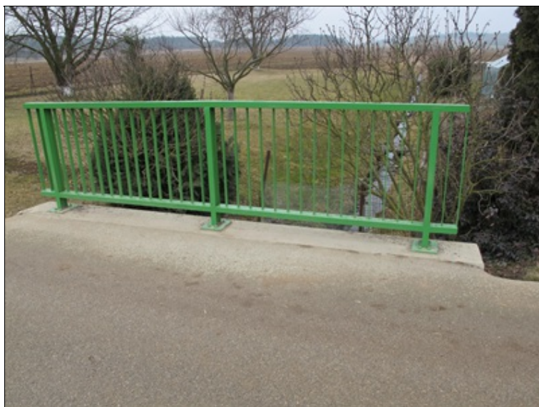
Vozovka na mostě převýšená až na horní úroveň říns.
