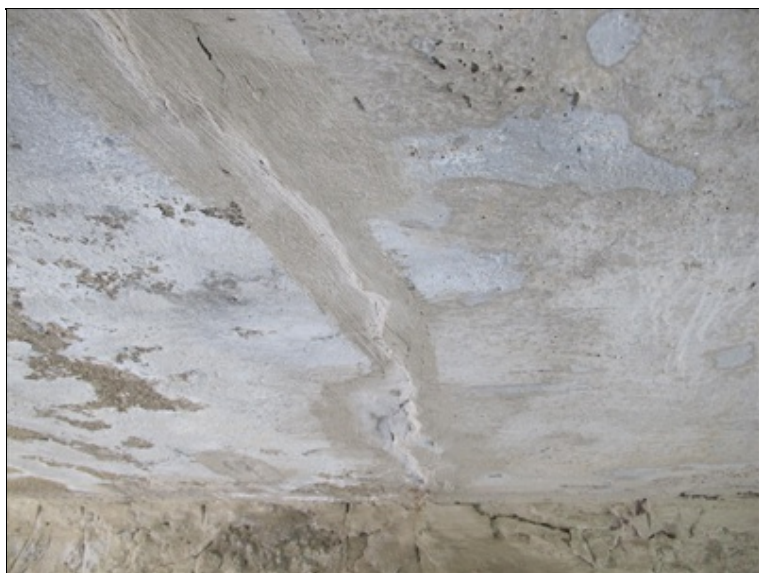
Podhled NK - podélné trhliny.
