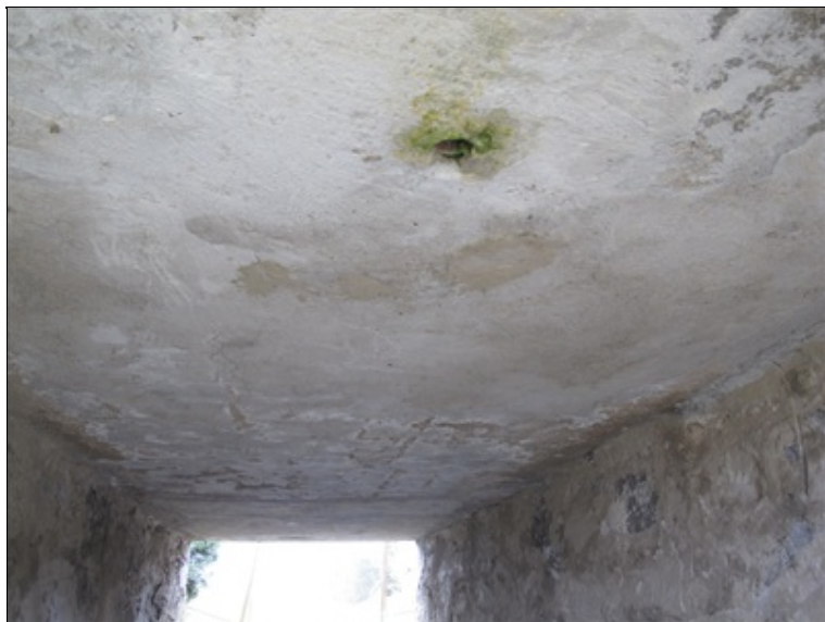
Podhled NK s vyústěním odvodňovače.
